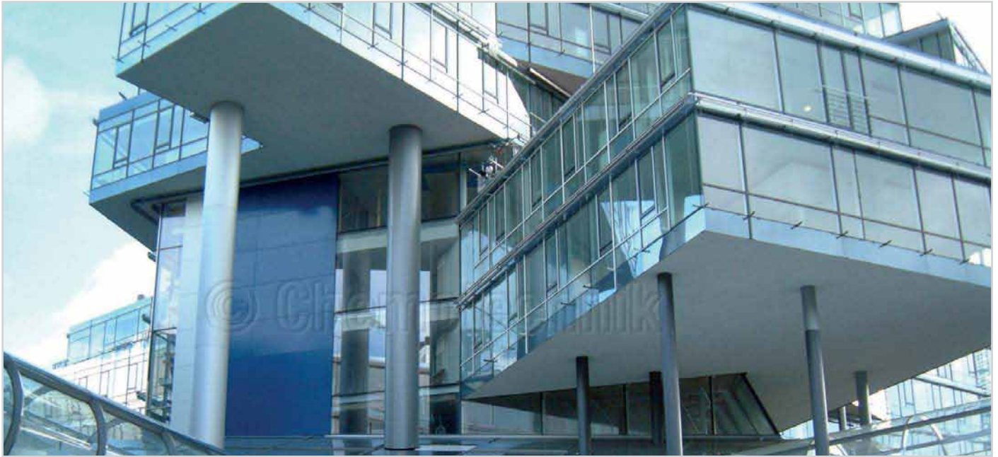
Landeszentralbank Hannover, Schwind- und spannungsfreier Estrich aus Thermorapid® Schnellzement
