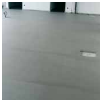
Glanzgradunterschiede in der Versiegelung
