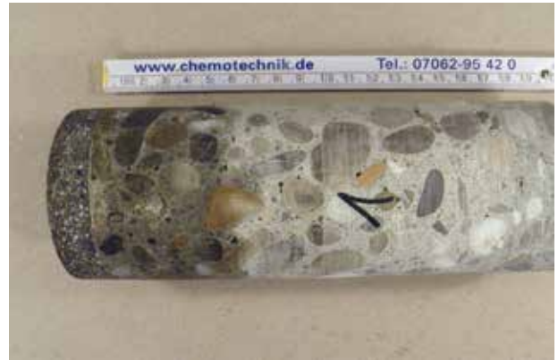
Stark verölter Beton unter Magnesiaestrich
