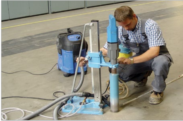
Bohrkernentnahme
