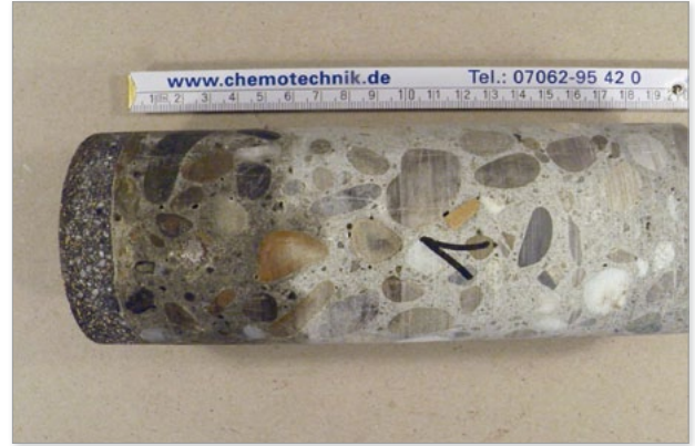
Stark verölter Beton unter Magnesiaestrich
