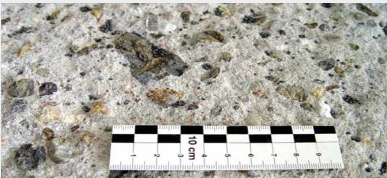
Fräs-/Strahlbild optimal: freigelegtes Korngefüge mit sichtbarem Kornbruch, Oberfläche rau und griffig
